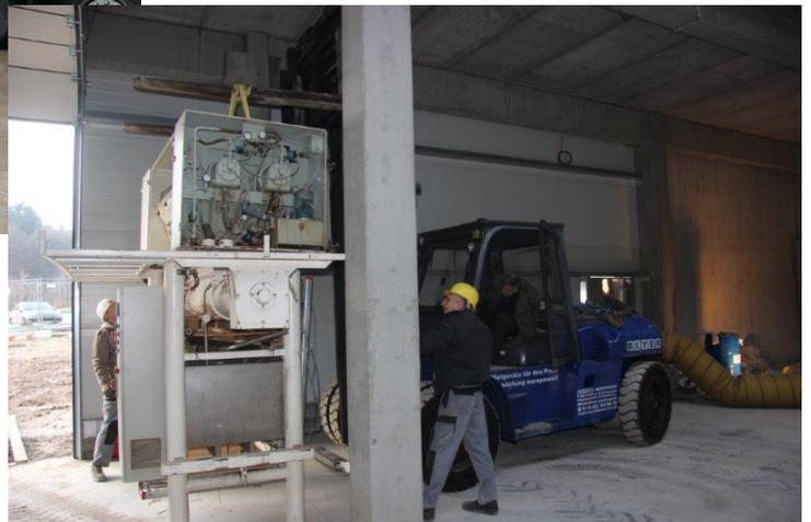
Demontage einer kpl Produktionsanlage (im Bild Kneteter 5to)
